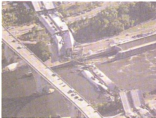
Рис. 31. Разрушение моста через реку Миссисипи (США) в августе 2007 г. как результат коррозии и ошибок в конструкции
