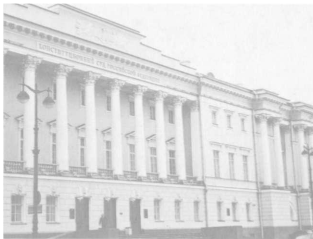
Рис. 1. Здание Конституционного Суда РФ в Санкт-Петербурге
